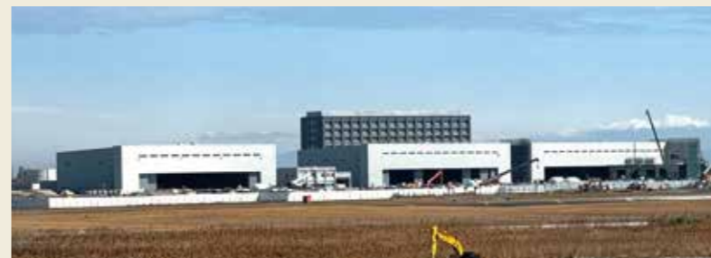
■佐賀駐屯地(仮称) 格納庫や隊庁舎も完成間近
