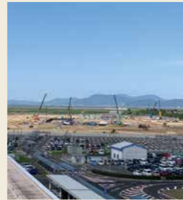
建設中の駐屯地
